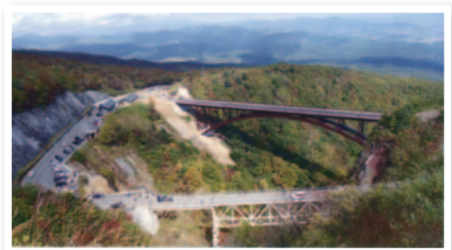
【③写真】不動沢橋架替工事
